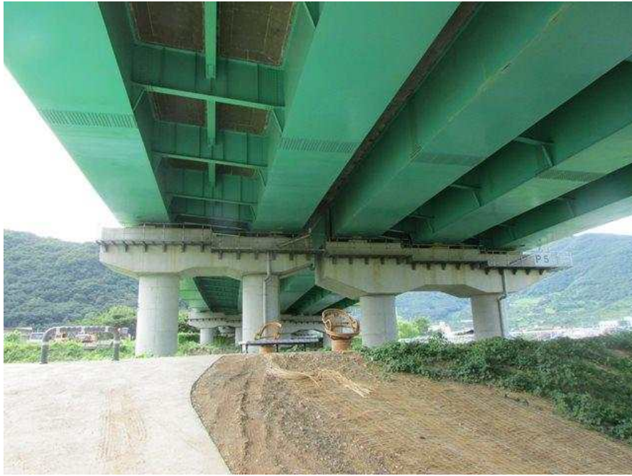
바닥판하면 및 강박스 외부전경
